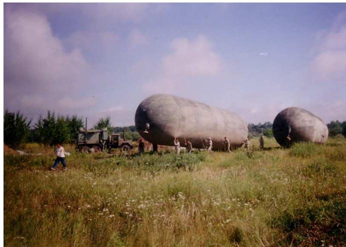
Рис. 4.27. Наповнення м'яких газгольдерів воднем від газогенератора
