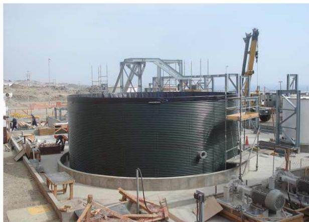
Рис.2.70. Монтаж гіbridного резервуара
