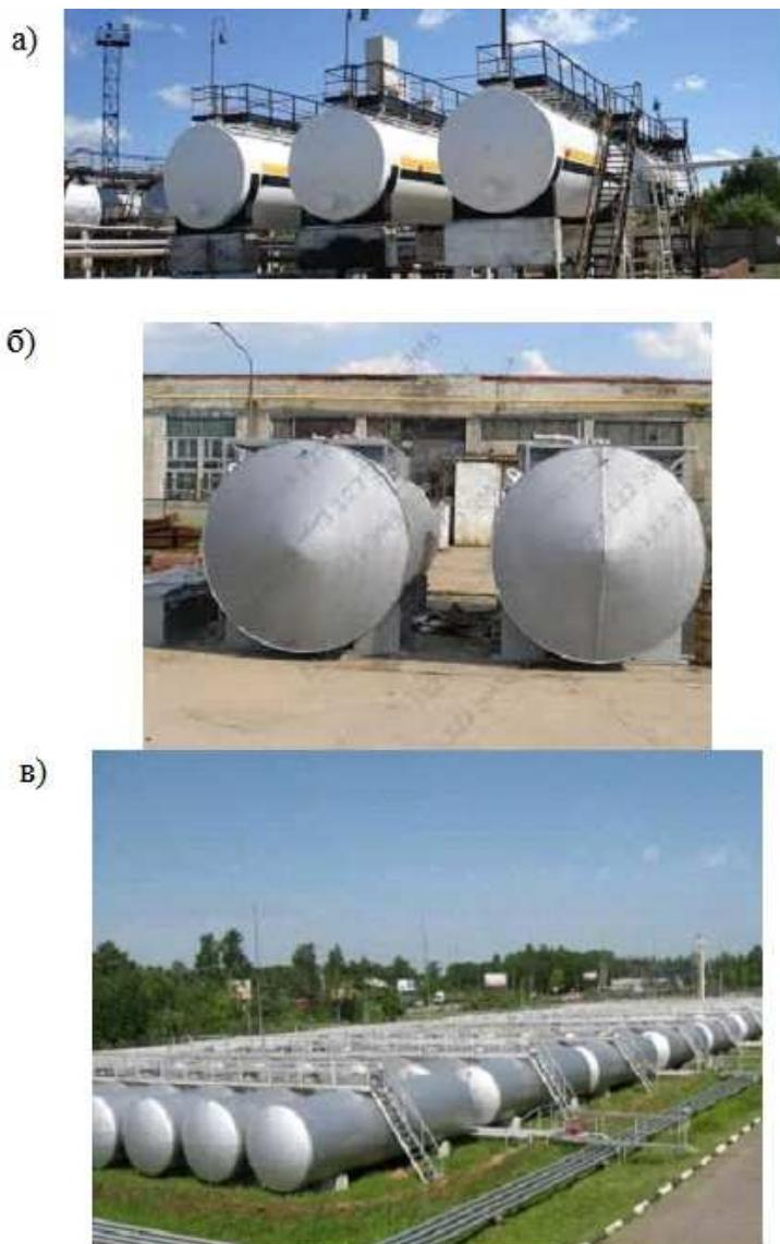
Рис. 2.46. Циліндричні резервуари з різними типами днищ:
