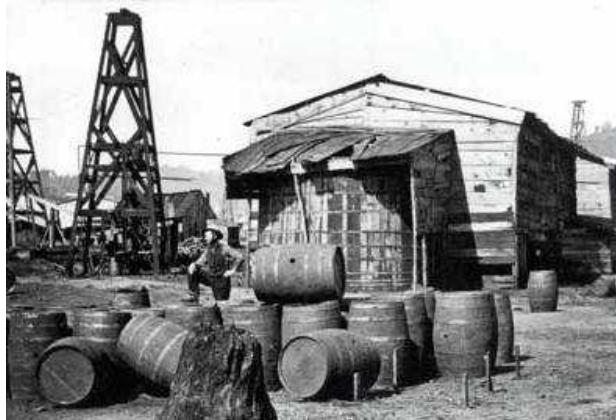
Рис. 1.3. Бочки для перевезення нафтопродуктів на нафтопромислі, на задньому плані – нафтова цистерна з дерева і комора над ямою для нафти
