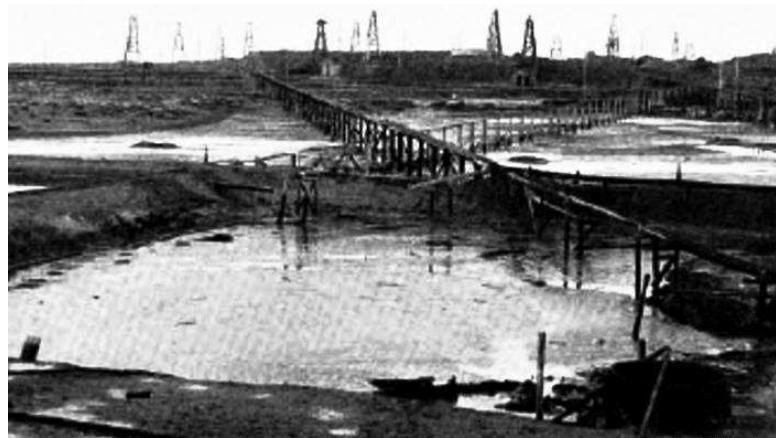
Рис. 1.4. Зберігання нафти в відкритих котлованах (коморах) на Бакинських нафтопромислах
