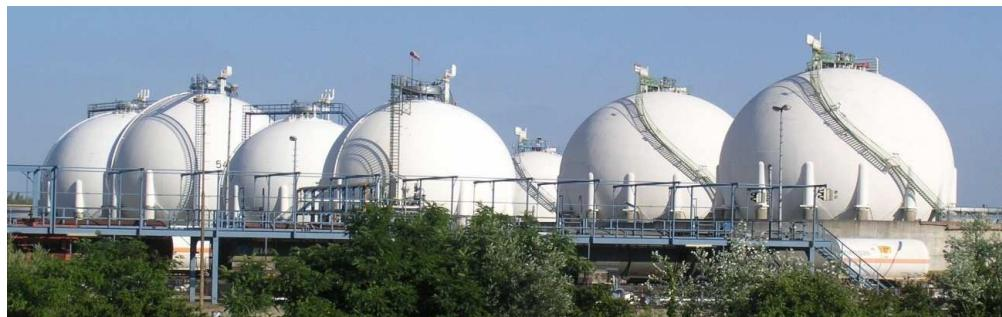
Рис. 2.60. Сферичні монолітні фібробетонні резервуари
