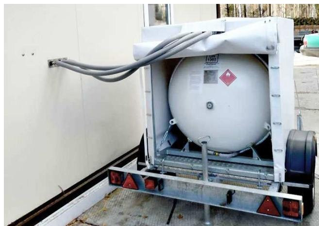
Рис. 4.69. Пересувний спеціалізований причіп-газгольдер до легкового автомобіля, підключений до системи опалення котеджу
