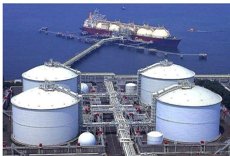
Рис. 4.50. Сталеві циліндричні газгольдери з плоским дном і сферичним дахом у складі портового терміналу з прийому зріженого газу
