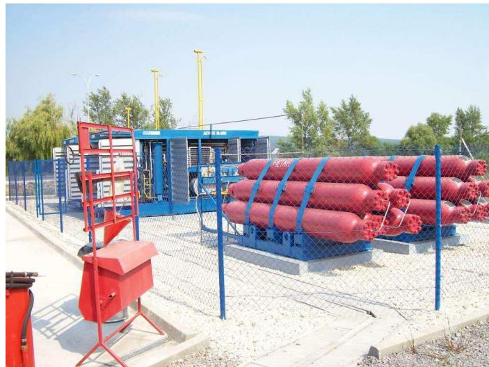
Рис. 4.30. Газові акумулятори на базі 500-літрових сталевих суцільнотягнутих газових балонів з двома горловинами в складі АГНКС
