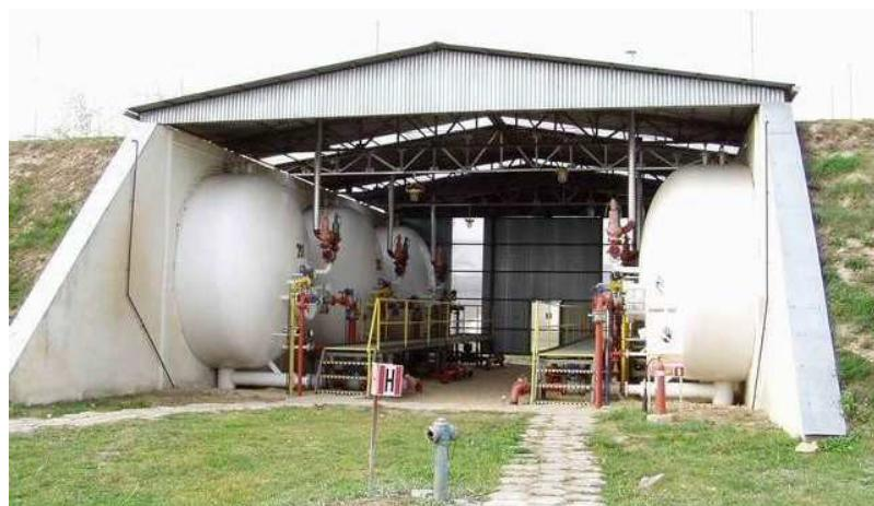
Рис. 4.56. Сховище, яке складається з горизонтальних резервуарів із засипанням
