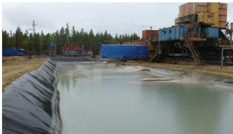
Рис. 2.73. Зберігання нафти у котловані з полімерним вкладишем
