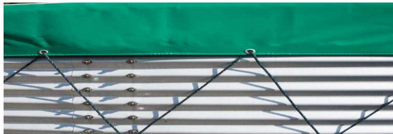
Рис. 2.71. Покрівля гібридного резервуара з гнучкою ПВХ мембраною
