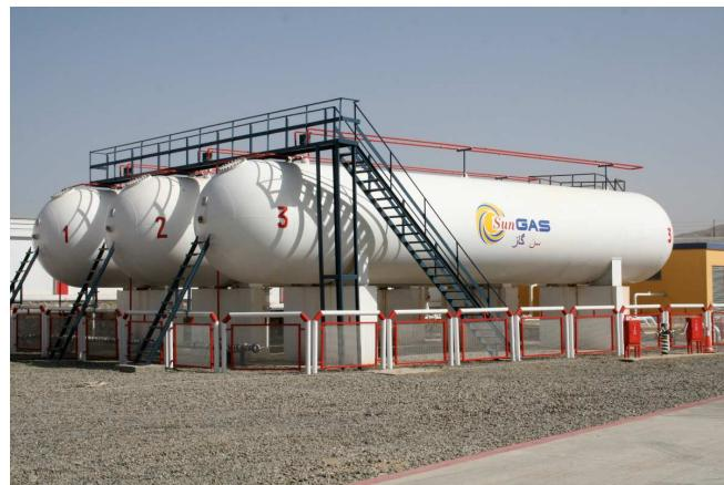
Рис. 4.19. Циліндричні горизонтальні газгольдери
