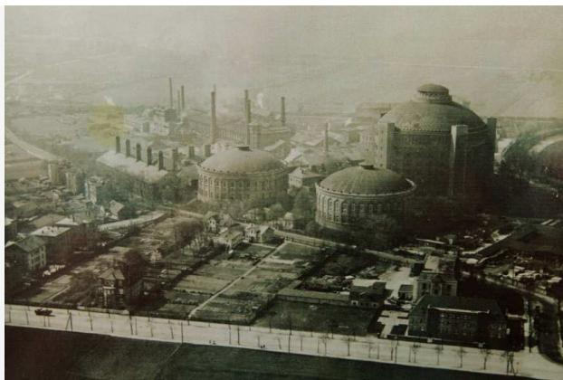
Рис. 4.1. Газовий завод з мокрими газгольдерами
