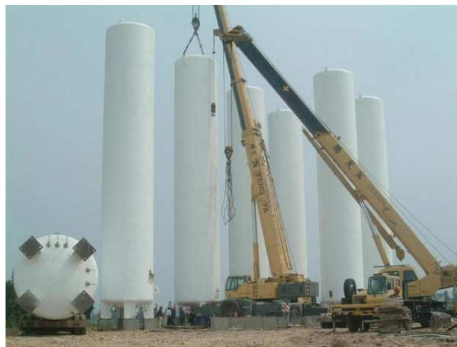
Рис. 4.20. Будівництво вертикальних газгольдерів
