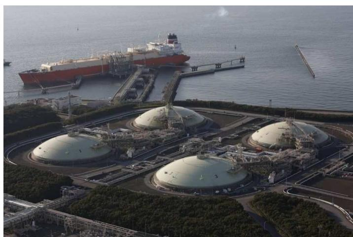
Рис. 4.64. Термінал прийому і регазифікації зрідженого газу
