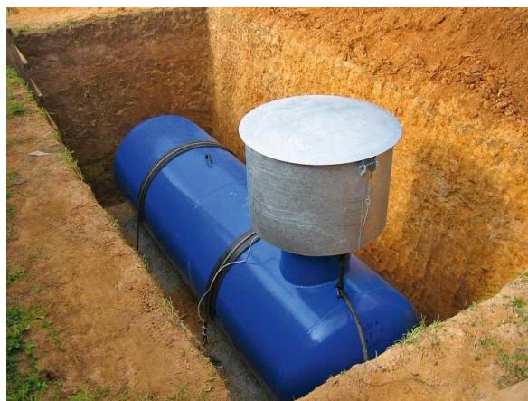
Рис. 4.57. Підземний горизонтальний газгольдер у котловані на фундаментній залізобетонній плиті (до засипання)
