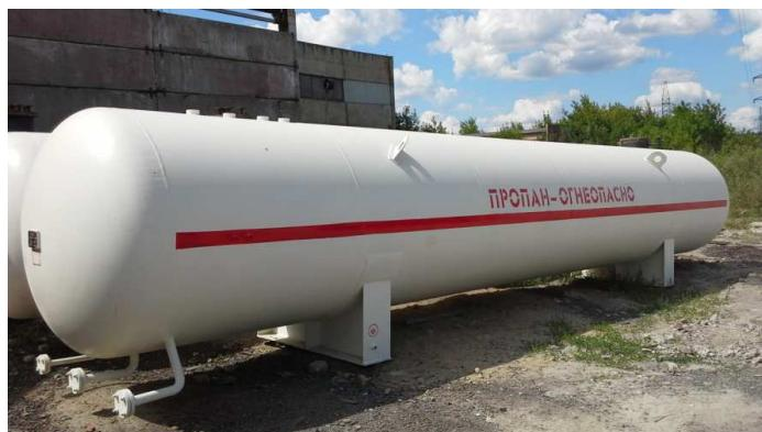
Рис. 4.55. Горизонтальний циліндричний надземний резервуар для пропан-бутану
