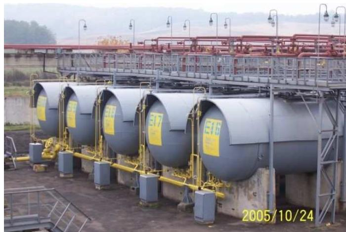
Рис. 4.60. Газгольдери під тіньовими козирками
