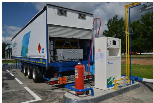
Рис. 4.43. Колонка дочірньої АГНКС с газовозом-напівпричепом
